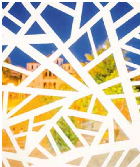
ΜΙΑ ΚΑΤΑΣΚΕΥΗ ΑΠΟ ΔΙΑΤΡΗΤΗ ΛΑΜΑΡΙΝΑ ΣΤΟΝ ΕΞΩΣΤΗ, ΜΕ ΤΗΝ ΑΦΑΙΡΕΤΙΚΗ ΠΡΟΣΕΓΓΙΣΗ ΕΝΟΣ ΔΕΝΤΡΟΥ, ΕΠΙΤΡΕΠΕΙ ΤΗ ΔΙΕΛΕΥΣΗ ΦΥΣΙΚΟΥ ΦΩΤΟΣ ΚΑΘΩΣ ΚΑΙ ΤΗ ΘΕΑ ΜΕΣΑ ΑΠΟ ΤΙΣ ΑΙΘΟΥΣΕΣ.
